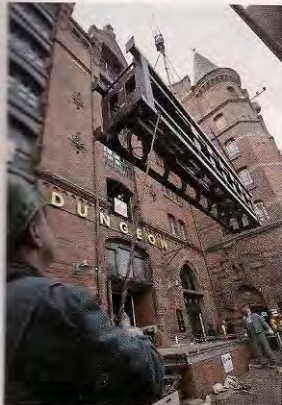
Logistische Meisterleistung: Der Einbau des Freifallturmes von ABC Rides im Hamburger Dungeon.
