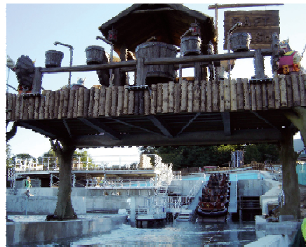
Die schöne Trollwaschanlage taucht leider nicht darüber hinweg, da es der Beton in Form unverbildet ist.
